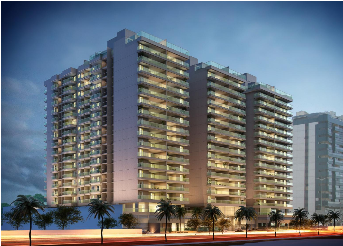
Edifício de uso residencial na Av. Estudante José Júlio de Souza
